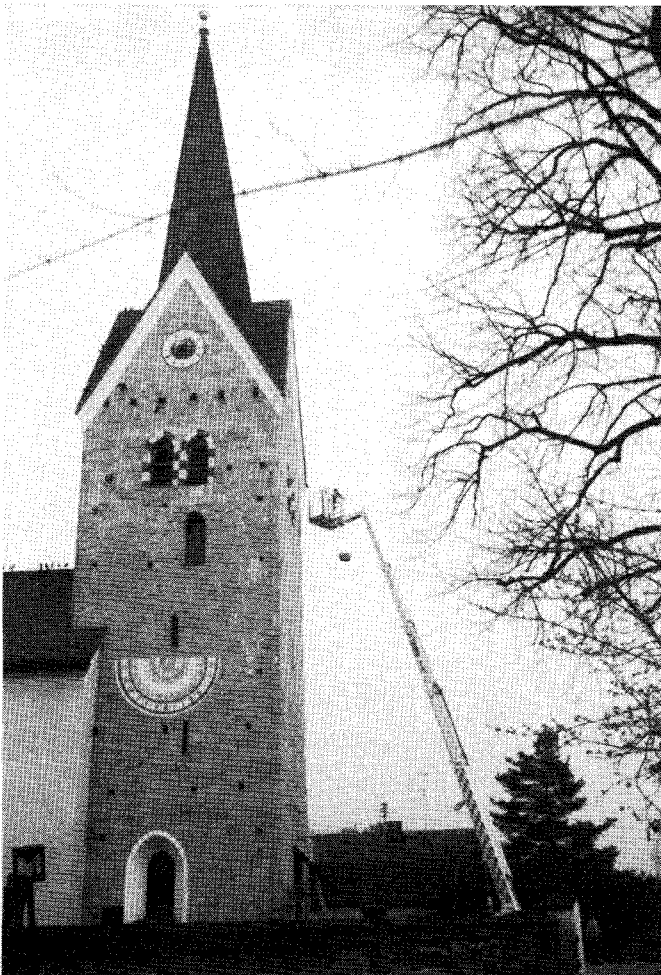
LBV-Handwerker in luftiger Höhe am Ascholdingener Kirchturm
