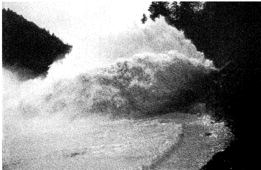
Auslaufbauwerk am Sylvenstein
